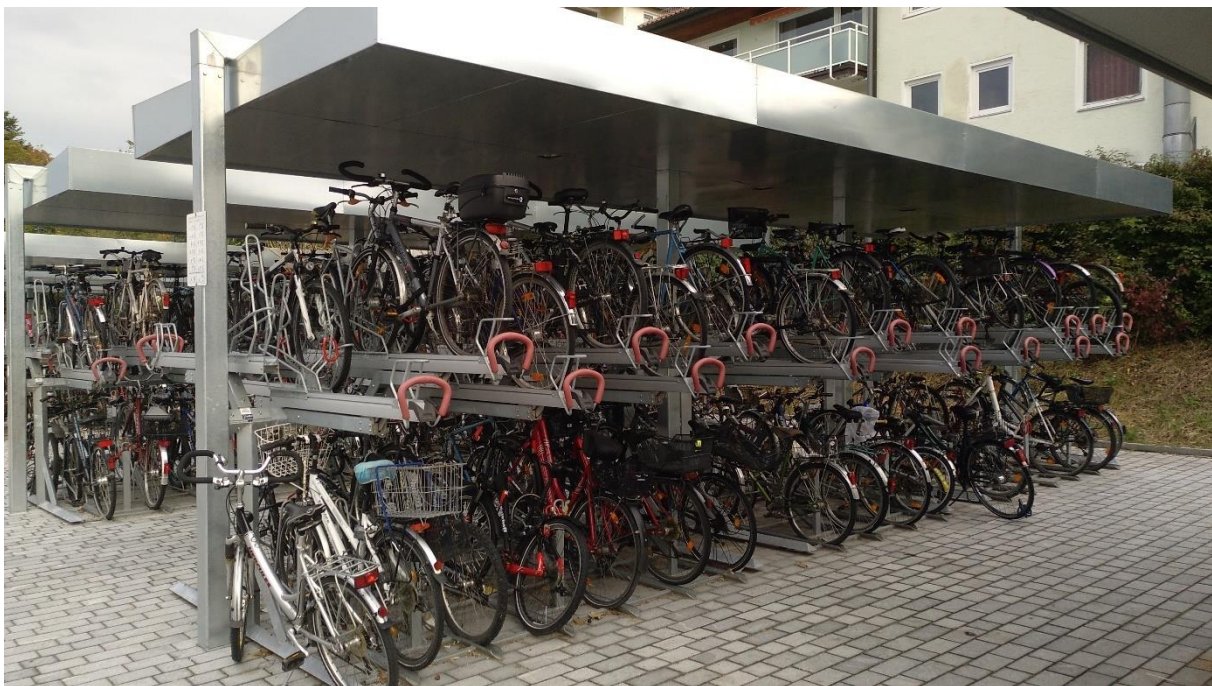
Abbildung 10 Doppelstockfahrradabstellanlagen am Bahnhof, hohe Kapazität, Überdacht und sicheres Anschließen möglich (eigene Aufnahme)
