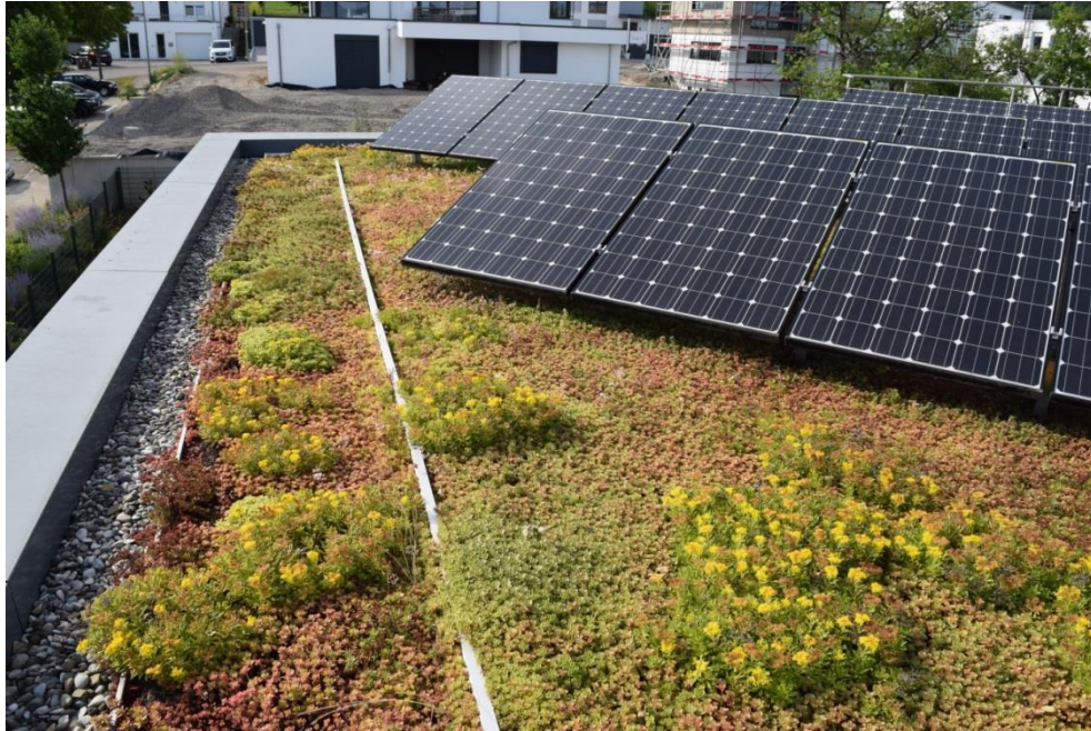
Abbildung 16: Kombination von Fotovoltaik mit Dachbegrünung, Foto: Dr. Gunter Mann, BuGG
