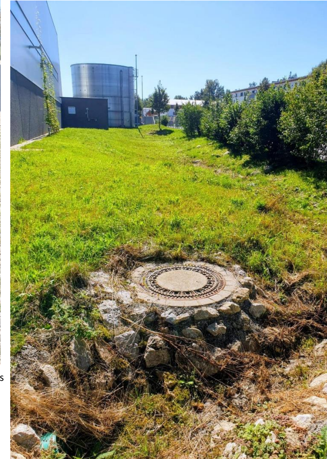
Sickermulde auf Betriebsgelände und Fassadenbegrünung des Betriebsgebäudes
