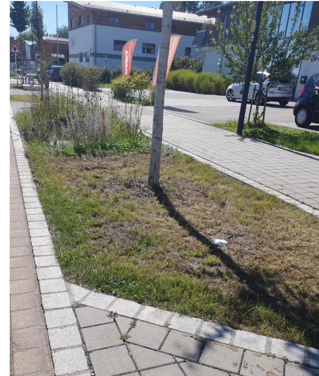
Bepflanzte Sickerflächen am Straßenrand, Versickerungsfähige Gehwege und Stellplätze im Gewerbegebiet Achalaich in Weilheim/Polling.
