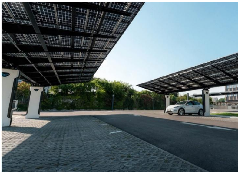
Abbildung 5-1: Beispiel für PV-Carport mit Ladesäule (Bild: KOCO Energy AG).
