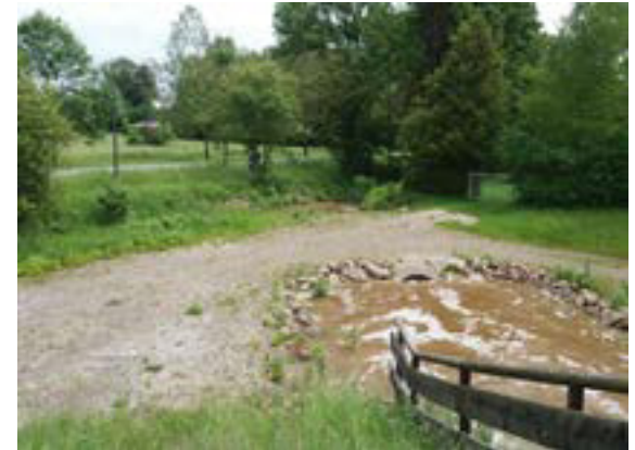
Hochwasserüberlaufbecken des Waitzackerbachs
